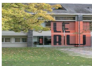
Repaire urbain Angers
